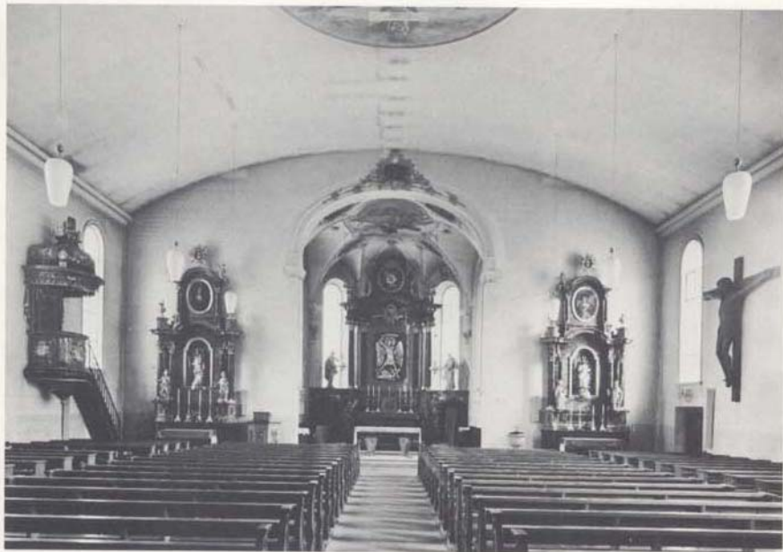
7 Pfarrkirche. Inneres gegen den Chor nach dem Schiffneubau von 1960/61
